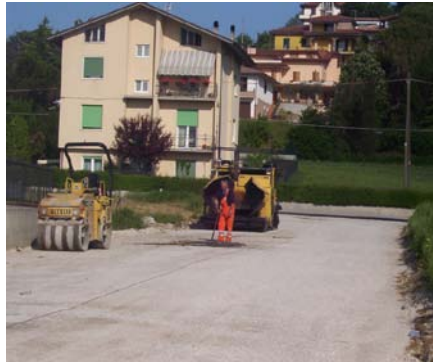
Asfaltature in corso
